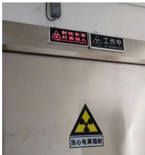
照片 4 工作状态指示灯及警示标识
